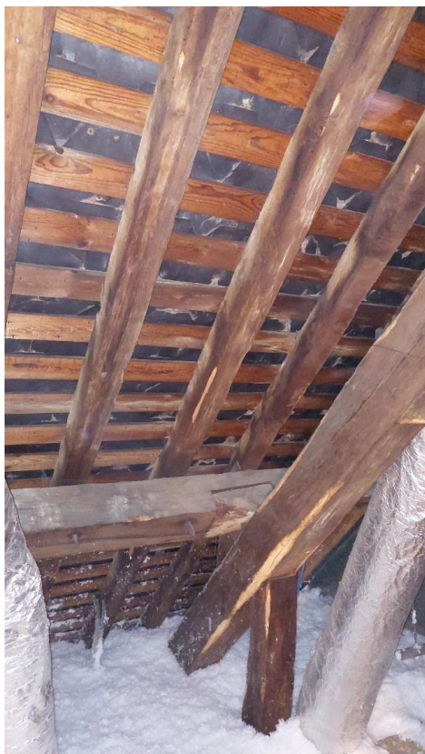
Photographie des charpentes existantes (à noter la présence de l'isolation soufflée à protéger).
