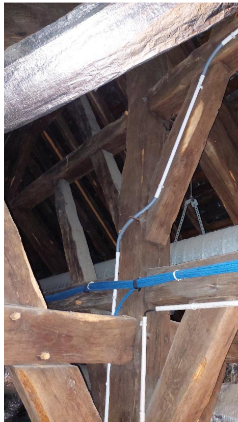
Photographie des charpentes existantes (à noter la présence de l'isolation soufflée à protéger).
