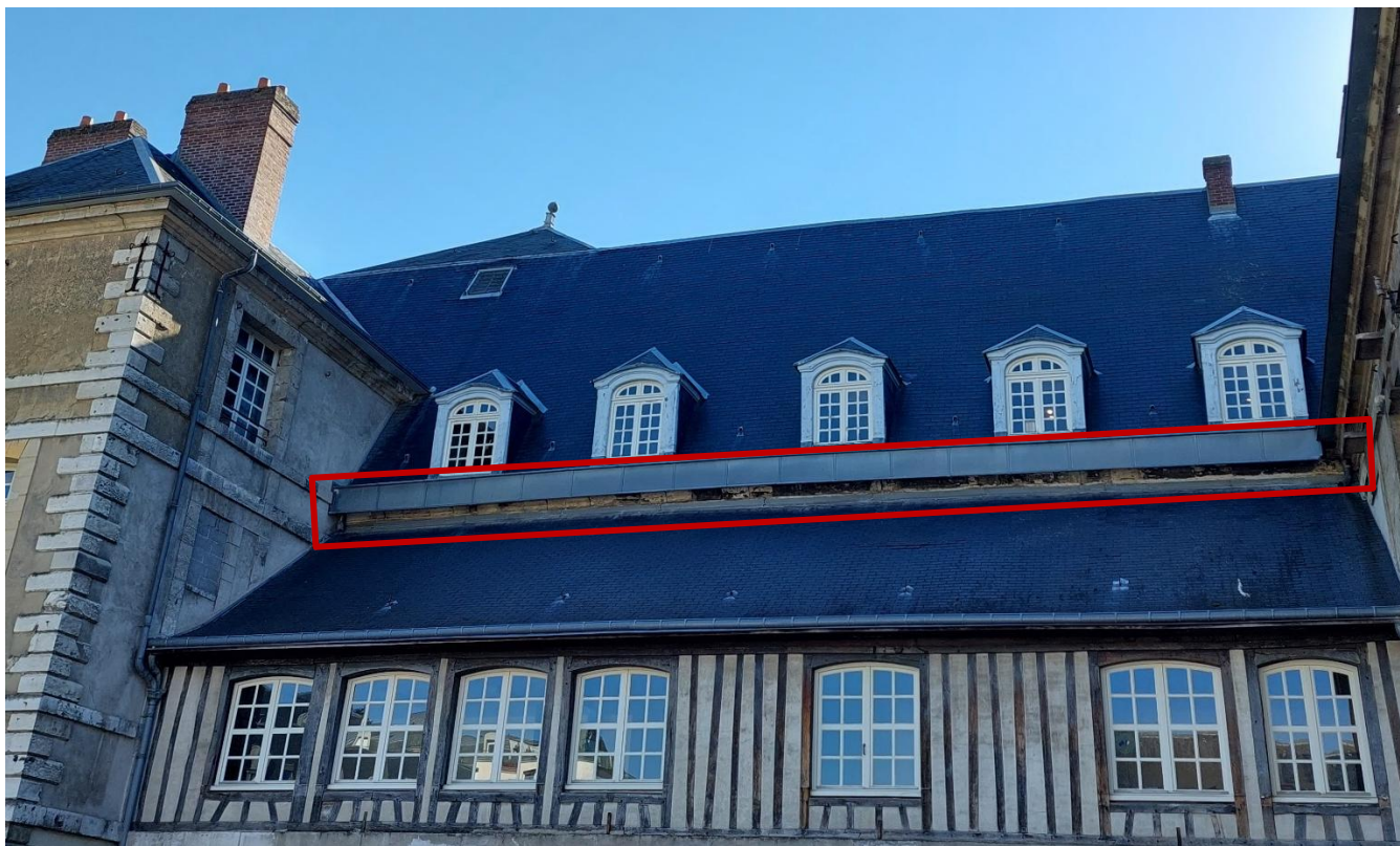
Photographie montrant des pierres de corniche endommagées
